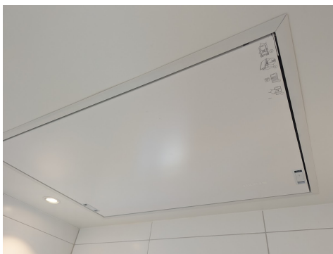
Ventilasjonsaggregat (takmontert)
