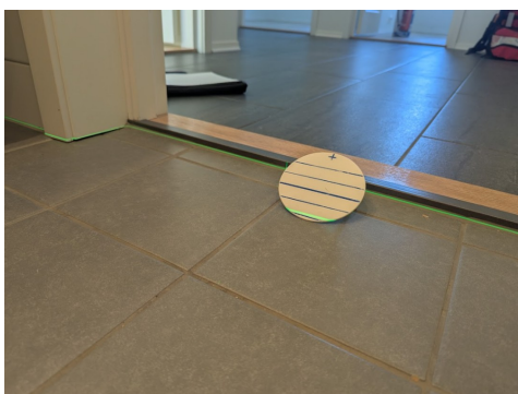
Måling av fallforhold på gulv
