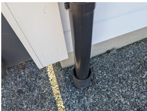
Taknedløp til rør i/under terreng
