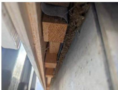
Underkant av kledning
