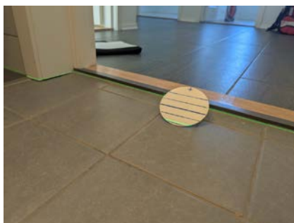
Måling av fallforhold på gulv
