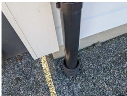
Taknedløp til rør i/under terreng
