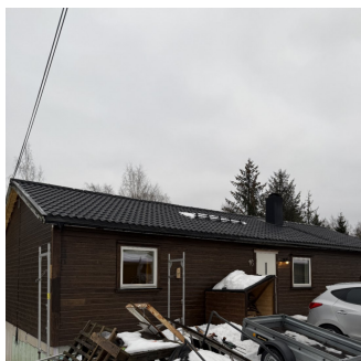
Mangler snøfangere og flassing på beslag
