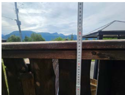
Rekkverk målt til ca.78cm.
