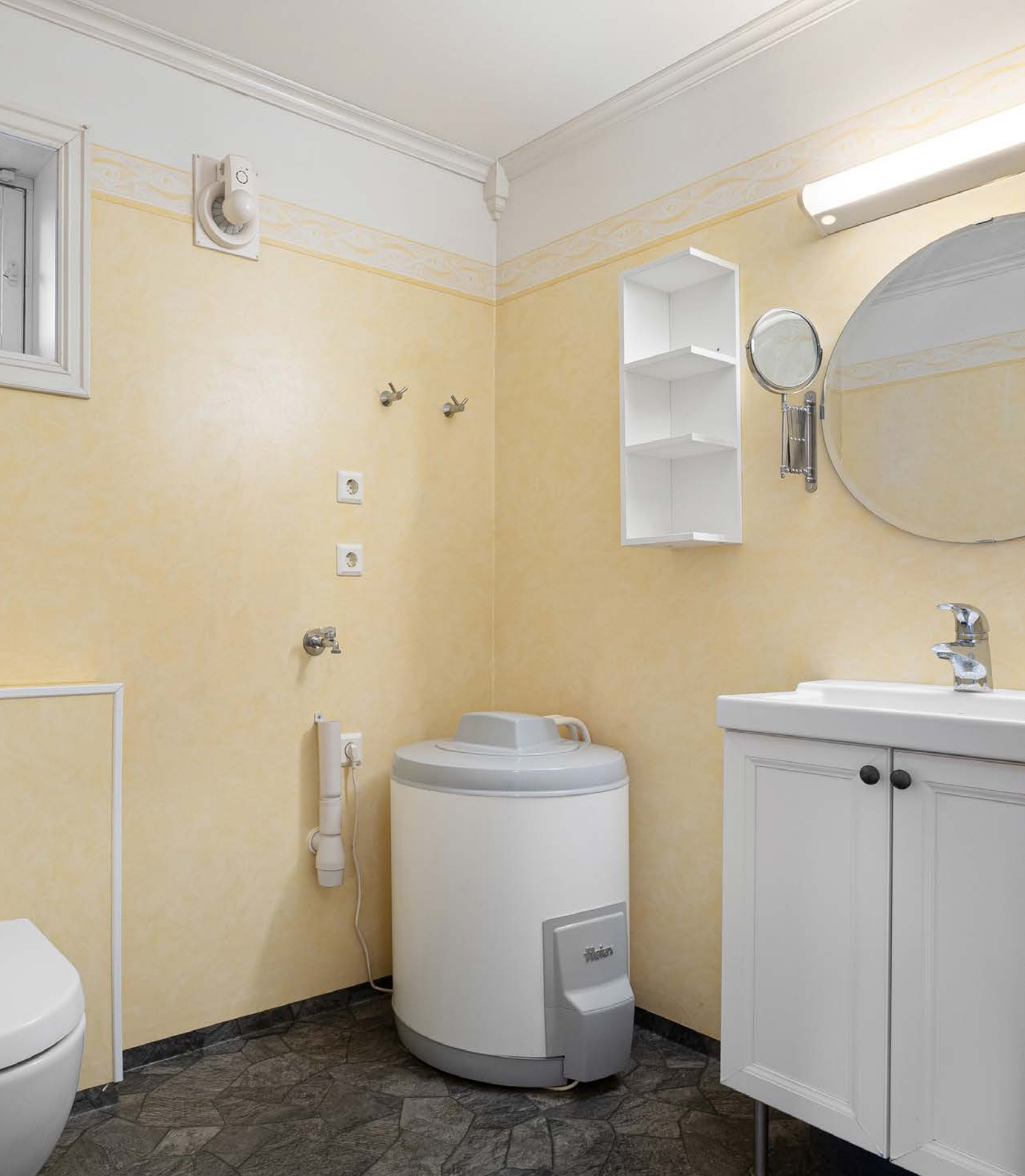
Underetasje hybel: Baderom med belegg på gulv.
