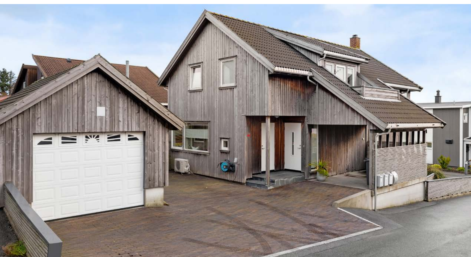
Romslig gårdsrom belagt med marktegl. Garasje med bod og to carporter.
