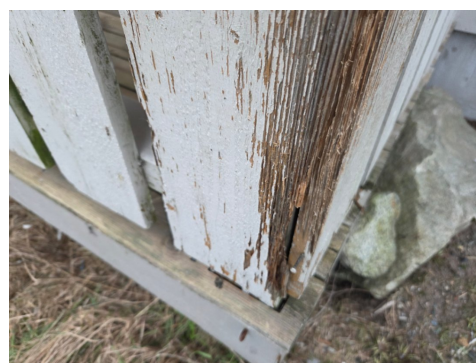
Råteskadet rekkverk
