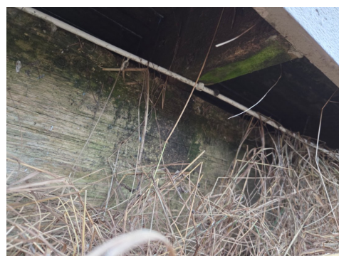
Råteskadet rekkverk
