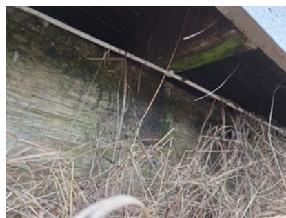
Råteskadet rekkverk
