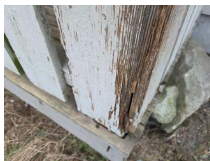
Råteskadet rekkverk
