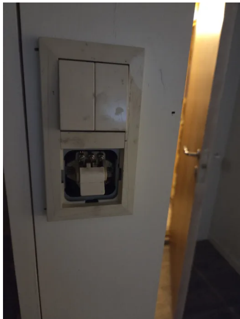
Deksel mangler på bryter.
