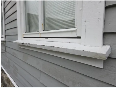
Oversiktsbilde av vindu og omramming.
