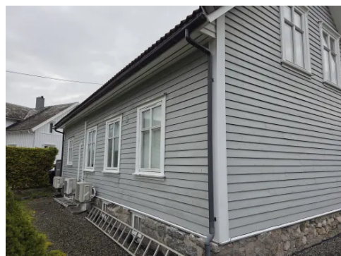
Oversiktsbilde av kledning.
