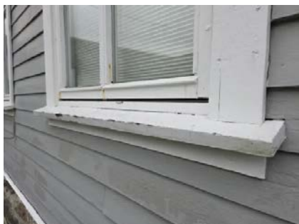
Oversiktsbilde av vindu og omramming.
