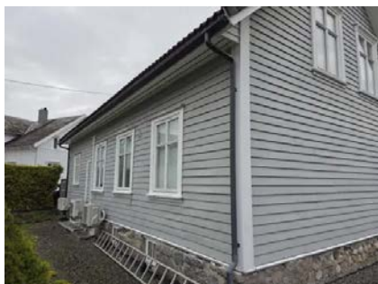
Oversiktsbilde av kledning.
