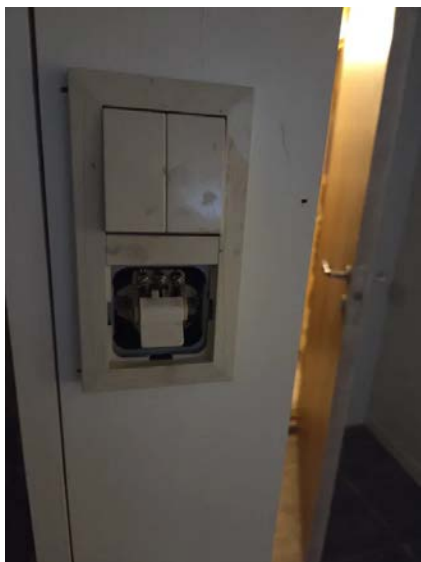
Deksel mangler på bryter.
