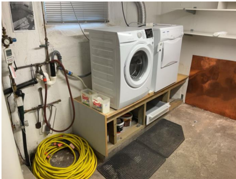
Vaskerom i kjeller.
