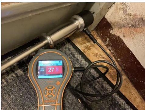
Måling av fukt i trappevange i kjelleren.
