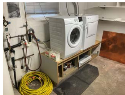
Vaskerom i kjeller.
