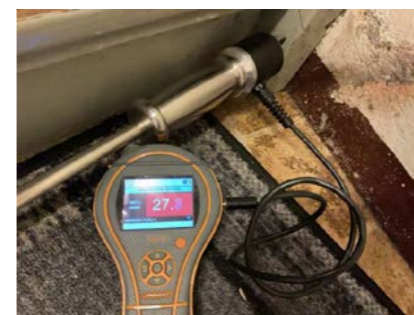
Måling av fukt i trappevange i kjelleren.
