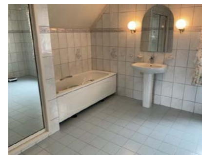
Bad i 2. etasje.
