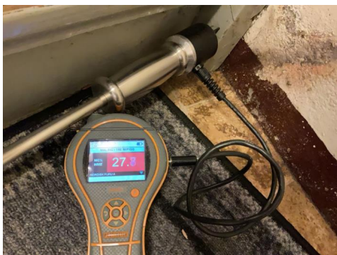
Måling av fukt i trappevange i kjelleren.
