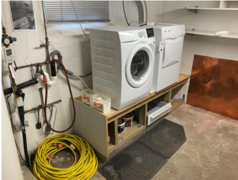
Vaskerom i kjeller.
