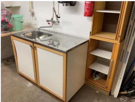
Innredning i vaskerom.
