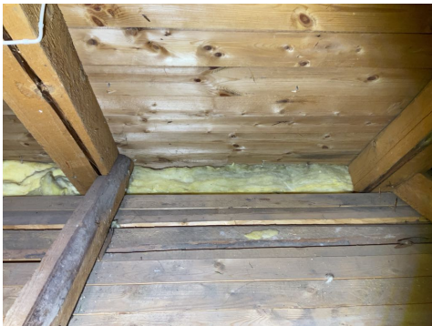
Det er isolert helt opp mot undertak.
