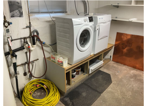
Vaskerom i kjeller.
