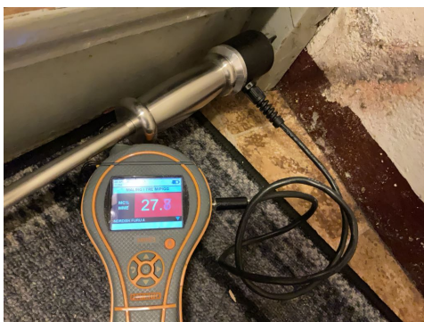
Måling av fukt i trappevange i kjelleren.
