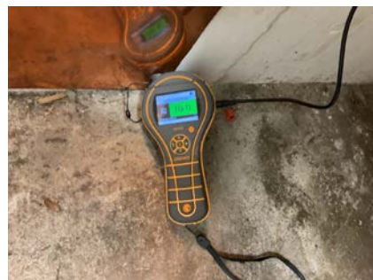
Fuktmåling i trevegg i vaskerom.
