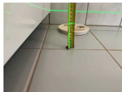
Høyde ved sluk.
