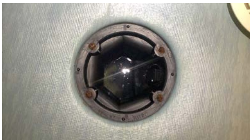
Plastsluk, og vinylbelegg er synlig ført under slukets klemring.
