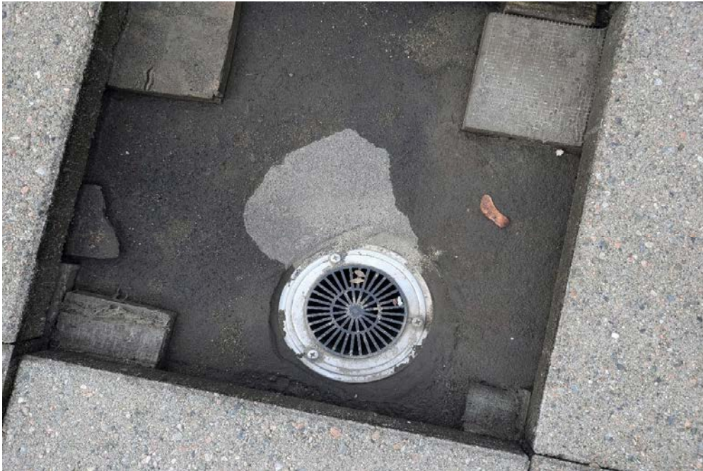
Bilde over viser sluk.
