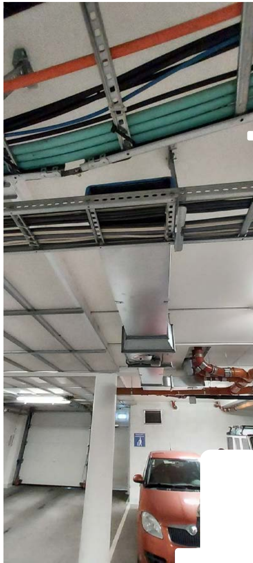
Avkastvarme fra leilighetene inn i garasjen.
