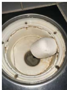
Sluk i plast, plassert i dusjnise i leilighet
