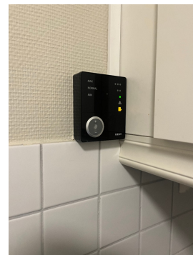
Styringspanel indikerer filterbytte.
