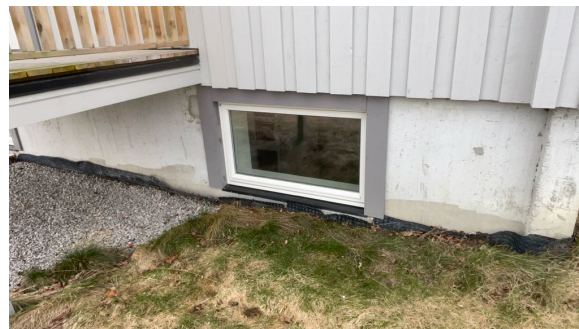
Vindu på soverom
