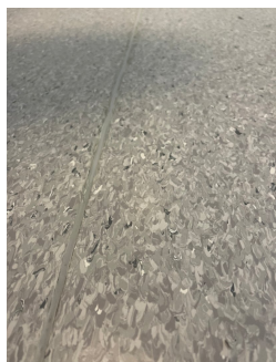
Sveiseskjøt på gulvbelegg er utbedret etter befaringen
