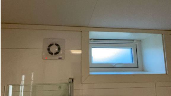
Mekanisk avtrekksvifte på vegg og åpningsvindu med ventil
