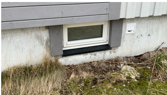
Vindu på bad
