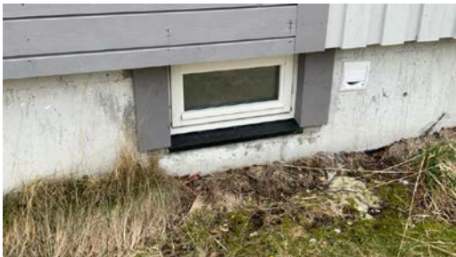
Vindu på bad
