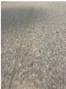
Sveiseskjøt på gulvbelegg er utbedret etter befaringen
