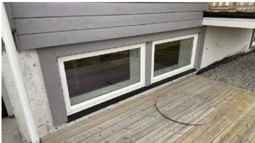
Vindu på stue
