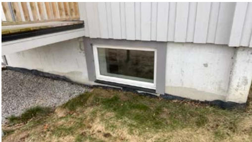
Vindu på soverom
