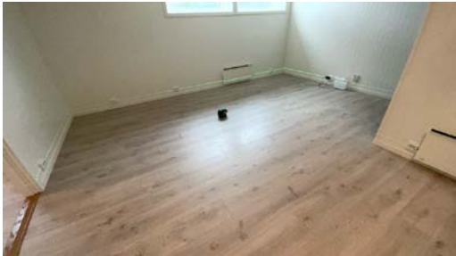
Kjeller. Plassering av laser ved kontroll av gang/stue/kjøkken. Det er målt 6 mm høydeforskjell gjennom rommet. TG 1
