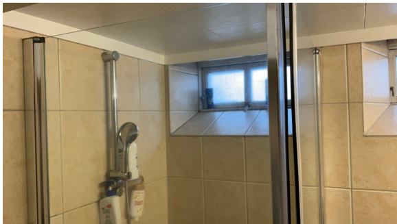
Vindu plassert i dusjsone
