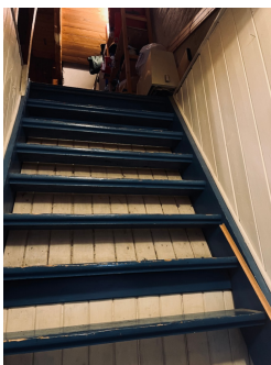
Kjeller: Lav høyde fra gulv og opp til tak, i nedre del av trapp.
