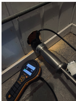
Hulltaking med fuktkontroll i yttervegg i wc.
