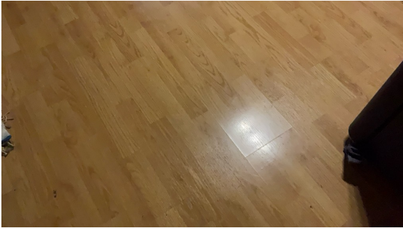
Laminatgulv i kjeller.
