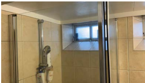
Vindu plassert i dusjsone
