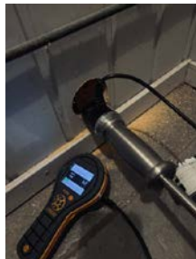
Hulltaking med fuktkontroll i yttervegg i wc.
