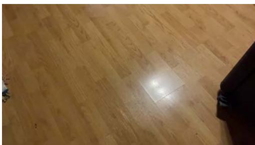
Laminatgulv i kjeller.
