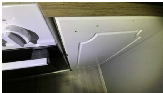
Enkelte småskader i fronter.
