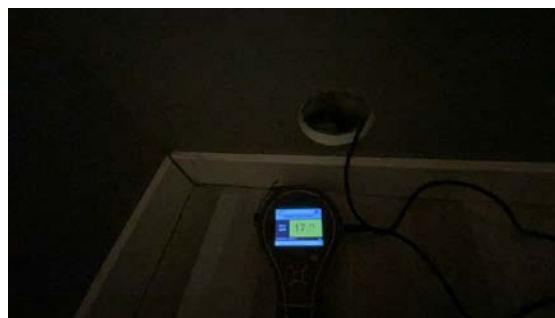
Det ble ved hulltaking målt 17,9 vektprosent i trevirke, da like over grenseverdi for tørt trevirke ved 17%.
