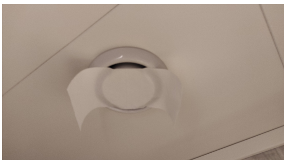
Funksjonstest av avtrekk.
