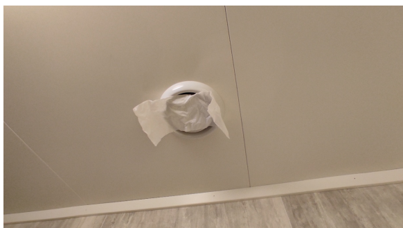
Funksjonstest av avtrekk.
