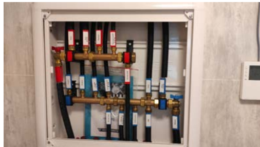
Kontroll av rørskap
