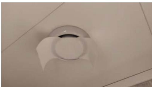
Funksjonstest av avtrekk.
