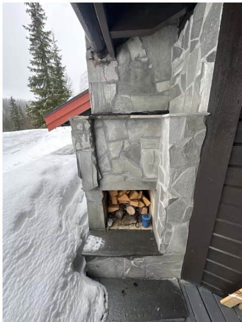
Viser utvendig åpen peis.
