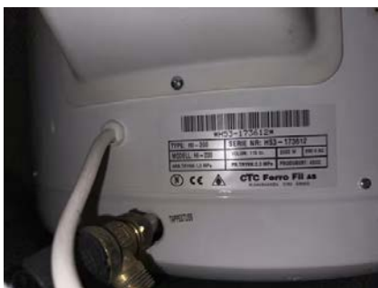
Viser teknisk data på bereder.
