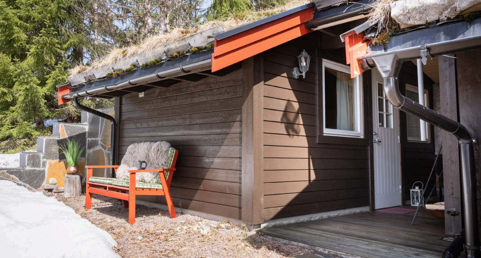
Inntilbygd anneks er isolert og har adkomst via overbygd terrasseplattning. Merk den fine leveggen på enden kledd i naturstein.
