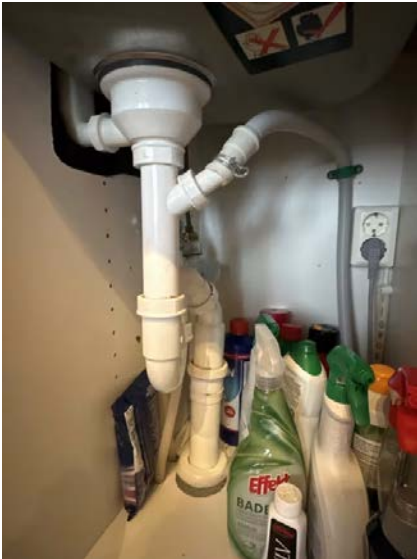
Viser vann og avløpsinstallasjoner under kum.
