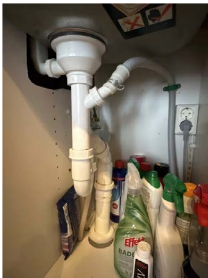
Viser vann og avløpsinstallasjoner under kum.
