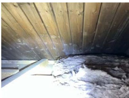
Ingen inndekning på åpning i sutak.
