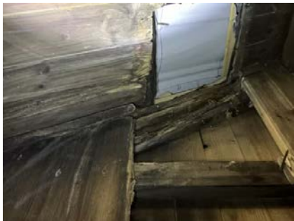
Ingen inndekning på åpning i sutak.
