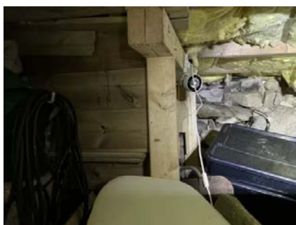
Del av bjelkelag er forsterket.
