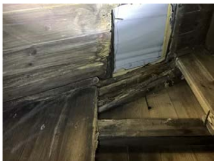
Ingen inndekning på åpning i sutak.
