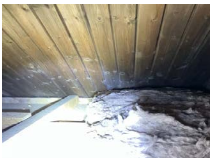
Ingen inndekning på åpning i sutak.
