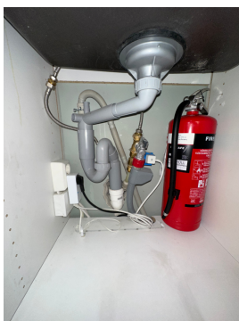
Rørapplegg i kjøkkenbenk med Waterguard
