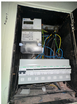
Sikringskap med automatsikringer.
