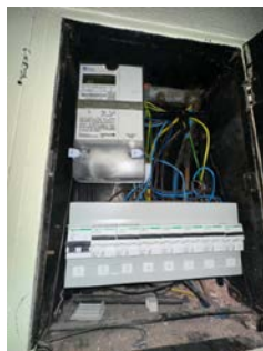
Sikringsskap med automatsikringer.
