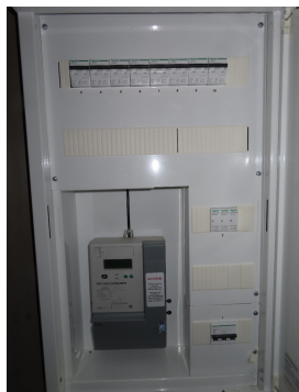
Sikringsskap med automater i vindfang.
