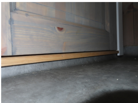
Belegg lagt ned oppkant til oppunder dør terskel som flomsikring.
