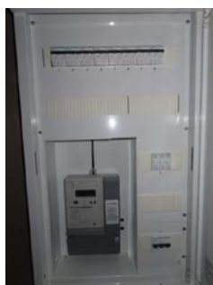
Sikringsskap med automater i vindfang.
