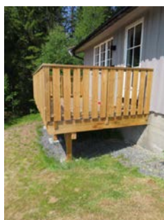
Veranda etter nedre langside - nyetablert og med punktfundamenter til fast grunn.
