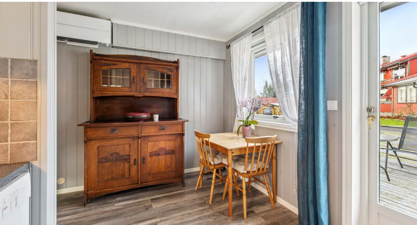
Ved kjøkkenet er det en nyere varmepumpe fra 2020.
