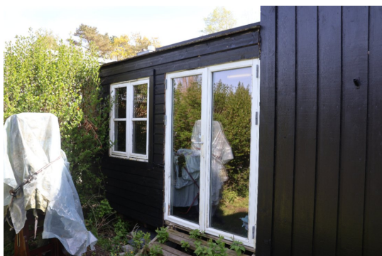
Det er laget overbygg over den ene terrassen. Enkelt laget.
