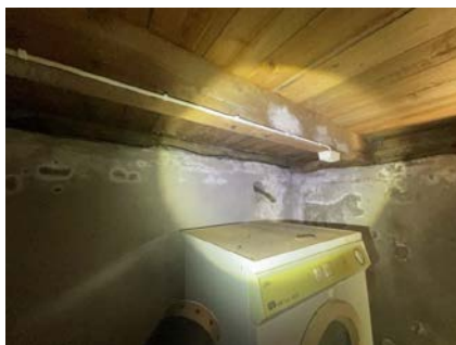
Grunnmur i kjeller, med tydelig kalkutslag flere steder.
