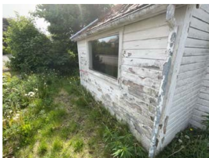
Malingslitasje kledning.
