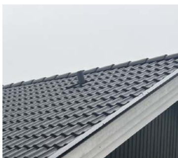
Takhatt vurdert til avløpslufting.
