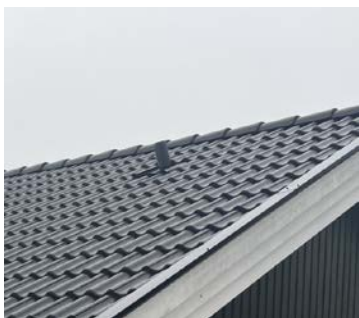
Takhatt vurdert til avløpslufting.
