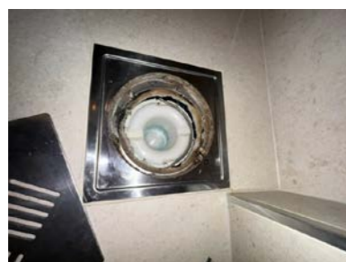
Sluk i plast, plassert i dusjnisje
