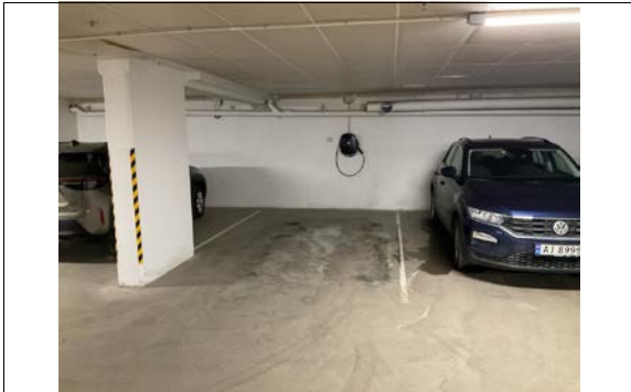
Biloppstillingsplass i felles garasjeanlegg i kjeller. EL-billader.
