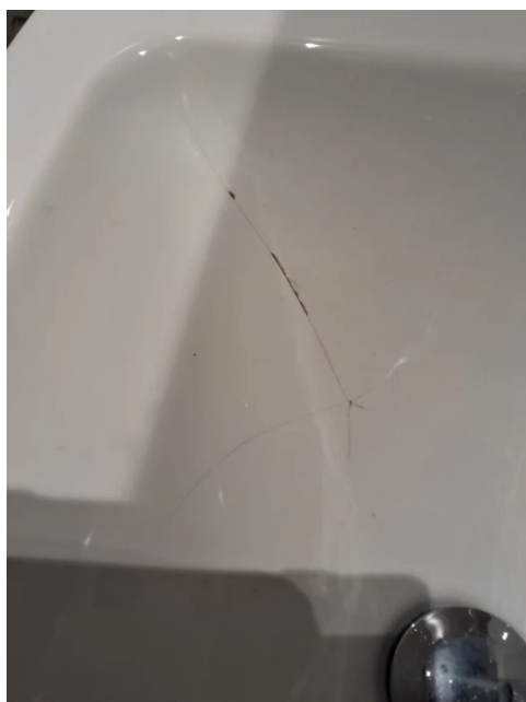
Oppsprekt porselen i servant.
