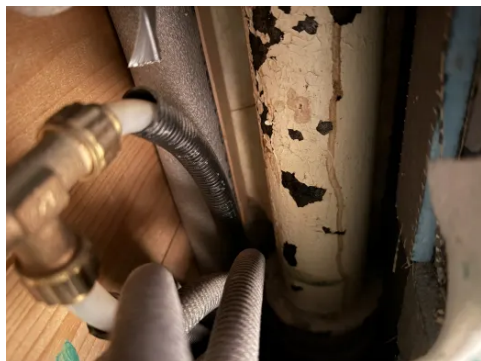
Det er synlige avløpsrør av støpejern i sjakt på bad.
