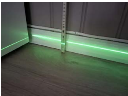
Etasjeskillet er kontrollert med nivelleringslaser.
