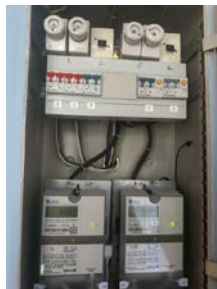
Sikringskap med originale skrusikringer.
