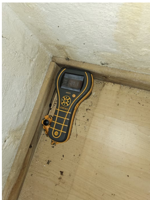
Bilde viser fuktmåling i kjeller.
