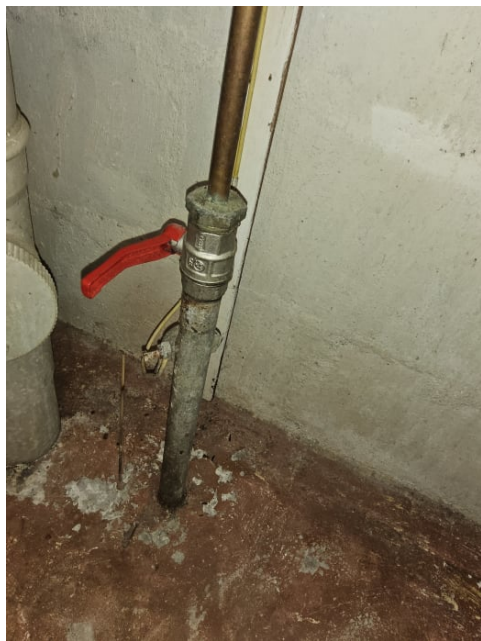
Bilde viser hovedstoppekran.
