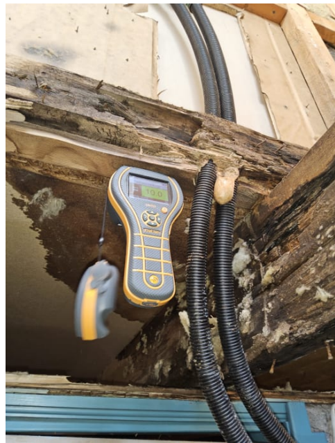
Bilde viser fuktmåling på vaskerom mot bad.
