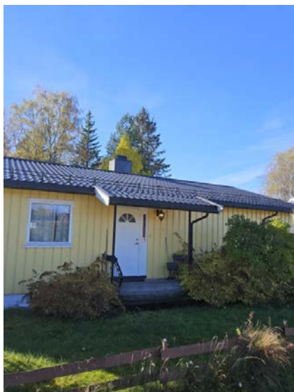
Bilde viser snøfanger.
