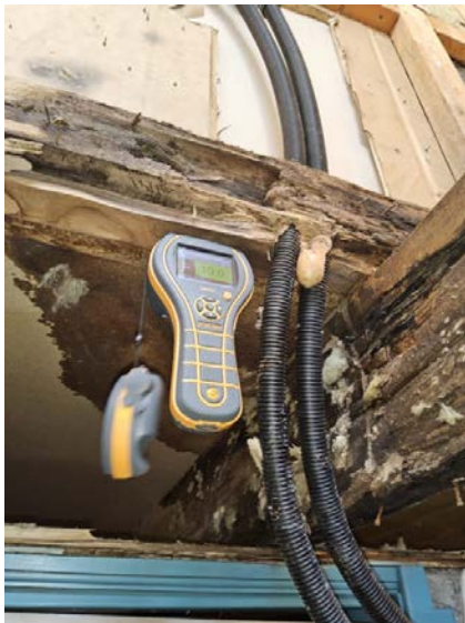
Bilde viser fuktmåling på vaskerom mot bad.
