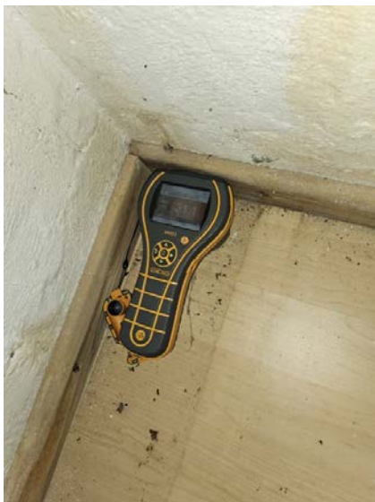
Bilde viser fuktmåling i kjeller.
