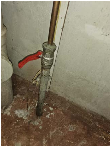
Bilde viser hovedstoppekran.
