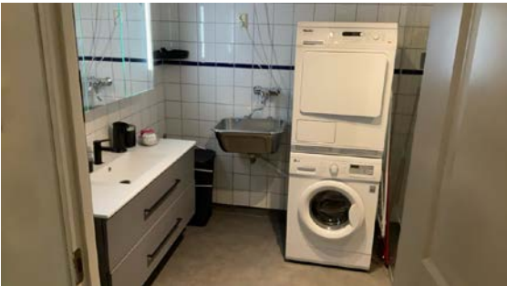
Bad med opplegg til vaskemaskin
