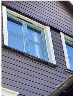
Mangler vindtetting under vinduet.
