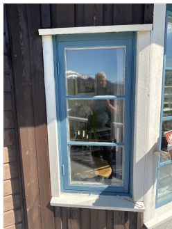
Mangler vindtetting under vinduet.
