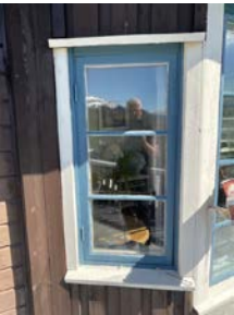
Mangler vindtetting under vinduet.
