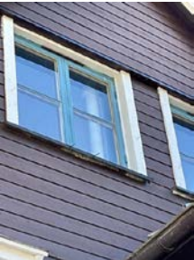
Mangler vindtetting under vinduet.
