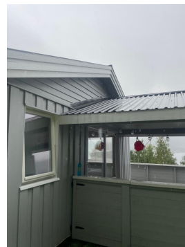
Ufaglig beslagsløsning ved vegg/tak
