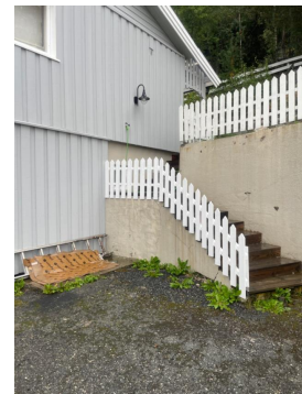
Betongtrapp mangler rekkverk.
