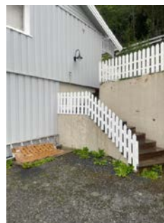
Betongtrapp mangler rekkverk.
