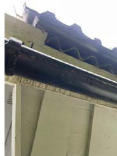
Synlig bølgeeternitt under taktekking.
